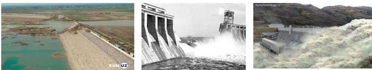
7-rasm. Hidrotexnik ob'ektlardagi avariylar
