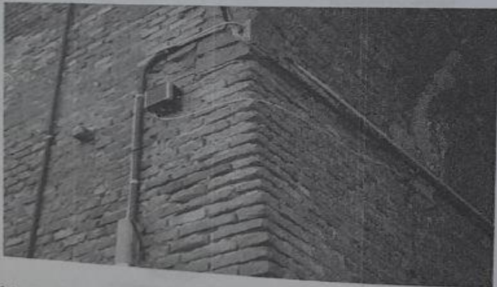
Рис. 5.14. Беспроводные датчики в системах мониторинга мостов
