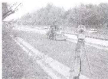
13.40-rasm. LEICA Geosistem tizimi bo'yicha yo'l qurilish mashinalarini boshqaruvi
