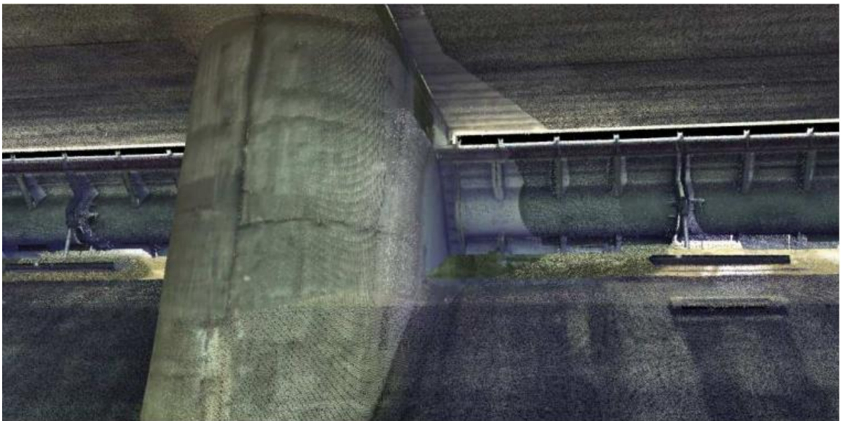
161-rasm. Besko to'g'onining o'lchash ishlari natijalari-suv oqib chiqish xuududidagi to'g'on modeli.
