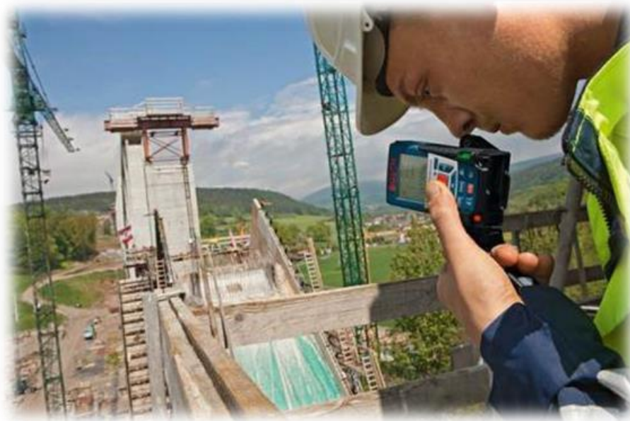
98-rasm. Suv inshootlarini qurishda lazerli dalnomerlardan foydalanish
