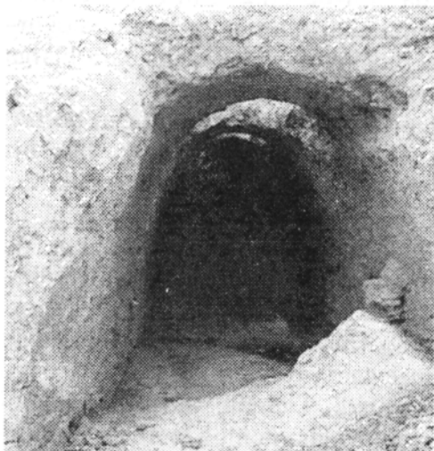
2.1.1-rasm. Ayoq qal'a. Ta'mirga muhtoj bo'lgan 2 mingyillik xomg'isht va paxsadan tiklangan inshoot.
