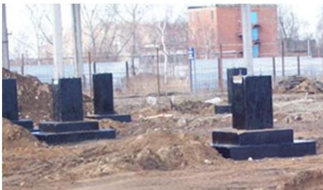
4.3-rasm. Yig`ma temir-betonli ustunsimon ko`rinishidagi poydevorlar
