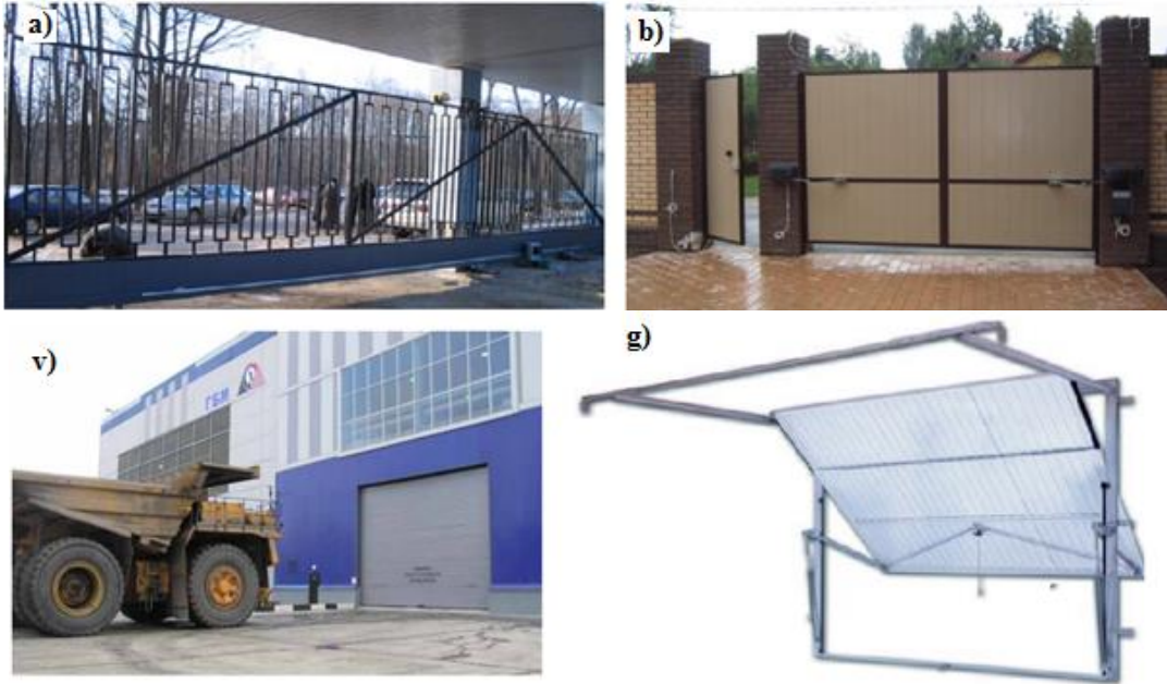
4.84-rasm. Sanoat binolari darvozalari a) surilib ochiladigan; b) tavaqali; v) ko`tarilib ochiladigan; g) ko`tarilib buriladigan.
