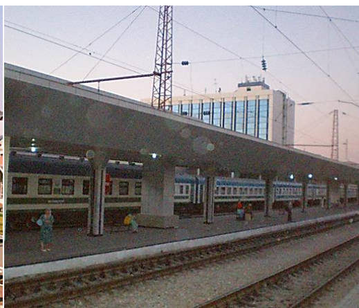
7.15-rasm. Toshkent stansiyasidagi usti yopiq yo`lovchilar platformasi
