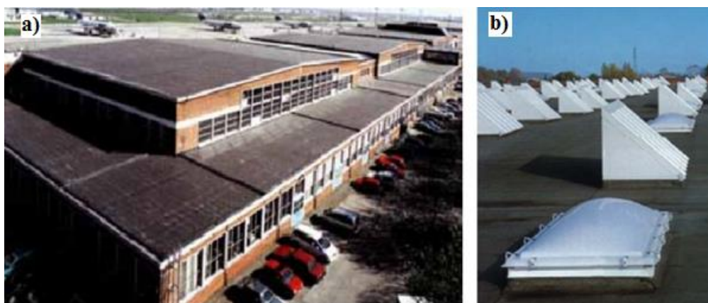
3.7-rasm. Sanoat binolari fonarlari a- to`g`riburchakli fonarlar; b- shedasimon va zenit fonarlari.
