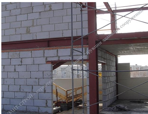
4.82-rasm. G'ovakli bloklardan ishlangan ajratuvchi parda devorlar
