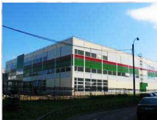
4.50-rasm. Yengilbetonli devor panellaridan iborat boʻlgan sanoat binosi tarzi
