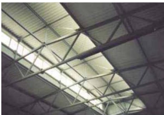
4.59-rasm. Profillangan po`lat listlardan iborat tom yopmasi
