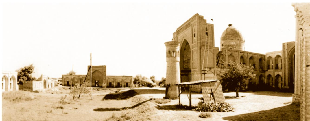
Мажмуанинг реконструкциягача бўлган умумий қуриниши
